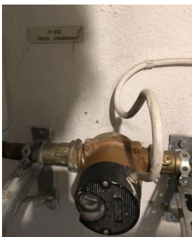
Figur 16: VVC-pump av äldre modell
