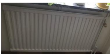
Figur 9: Radiator i lgh med endast handvred
