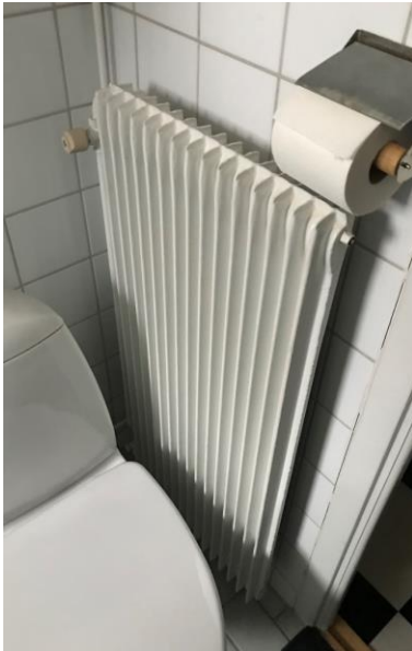
Figur 12: Handdukstork/radiator ev. kopplad på VVCn
