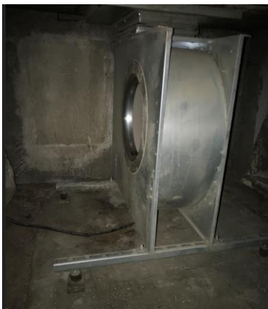
Figur 14: Ventilationsfläkt
